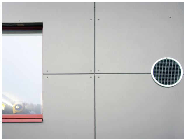
Vue détaillée de la façade
