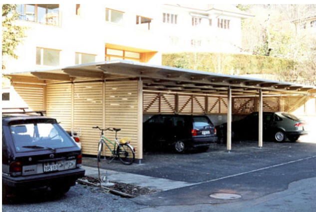
Abri pour voitures terminé
