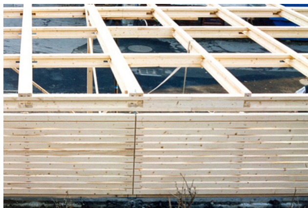
Abri pour voitures terminé
