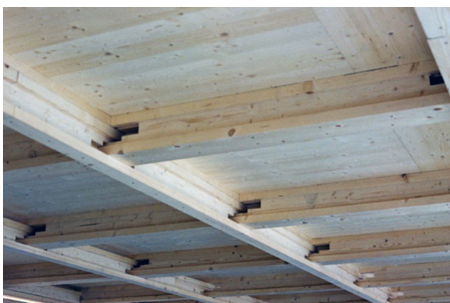
Grille de support terminée
