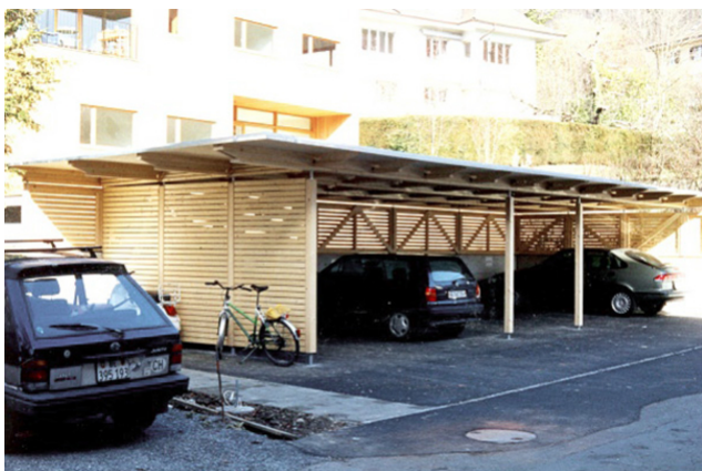
Abri pour voitures terminé
