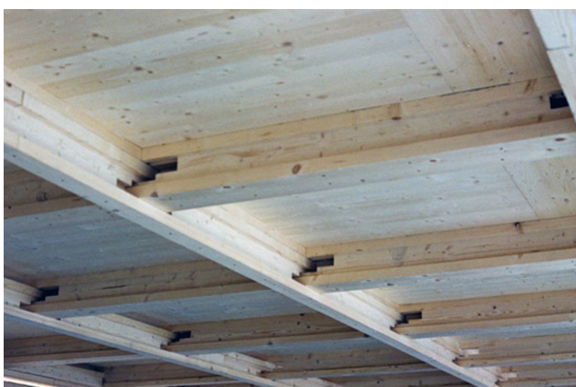
Grille de support terminée
